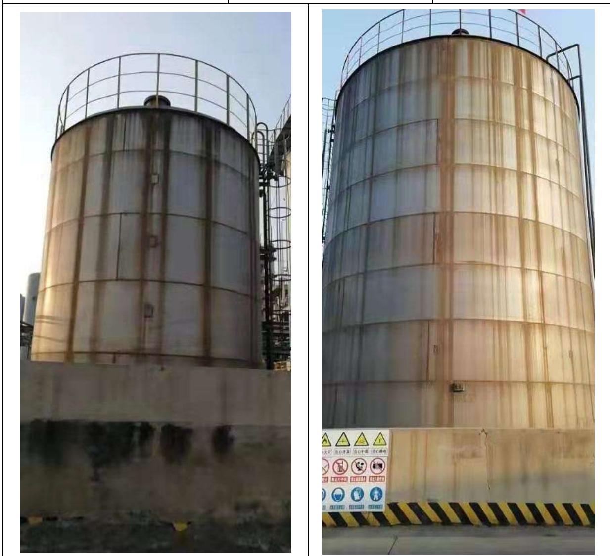
DMF 及甲醇罐区
